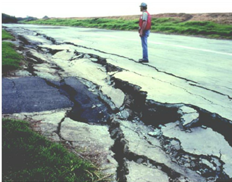
รูปที่ 10 ลักษณะของ Lateral spread ที่เกิดขึ้นบนถนนในประเทศสหรัฐอเมริกา สาเหตุจากแผ่นดินไหว ( คัดลอกจาก L.M. Highland and P. Bobrowsky, 2008)
