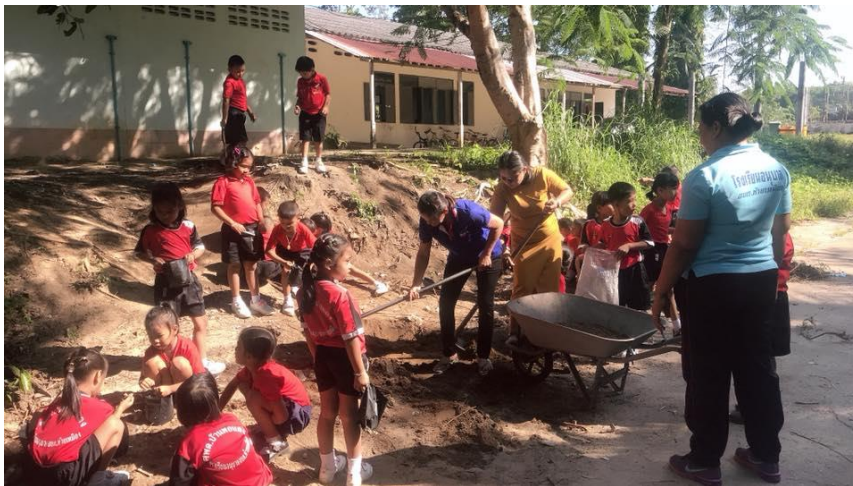
ขุดดินขนไปใส่แปลงผัก
